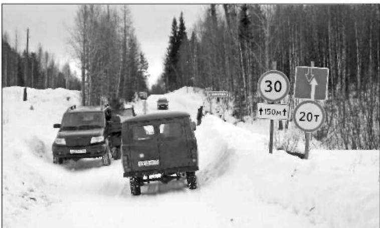
Мост на Выкомше используется интенсивно.
